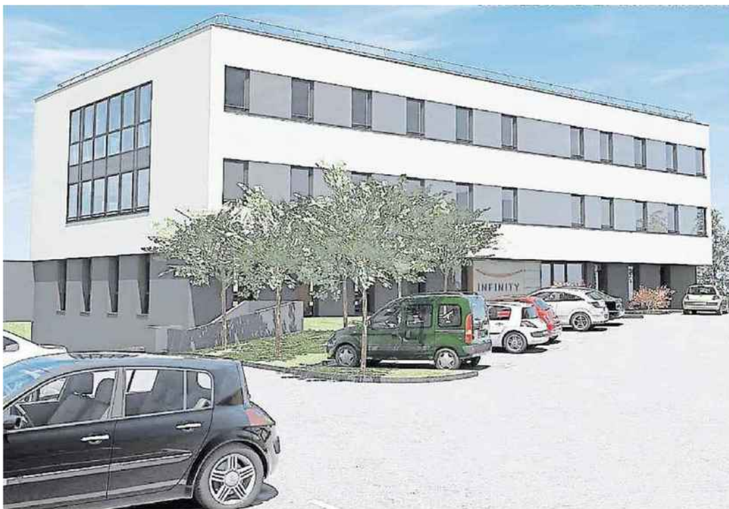
Le bâtiment, en cours de construction, devrait voir le jour au printemps 2017.
